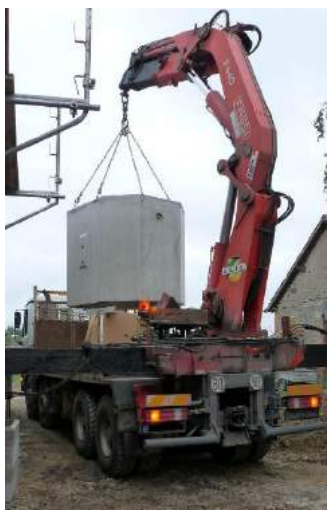
Levage d'une cuve en béton
