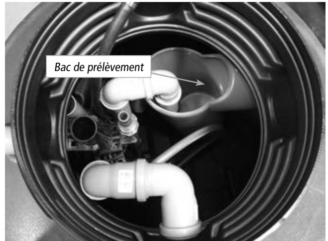
Vue du dessus d'une rehausse de micro-station ACTIBLOC® LT 30-25 4EH avec bac de prélèvement dans le réacteur.
