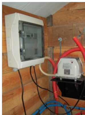
EL-S-60 monté dans un coffret insonorisé et coffret de commande
