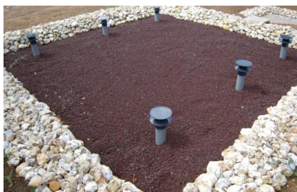
Vue du système de répartition avant la fin du remplissage de substrat spécial.
