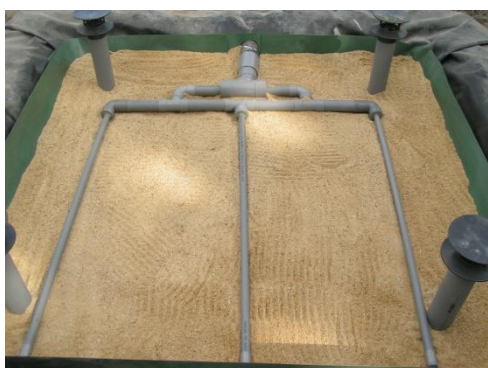
Vue du système de répartition avant la fin du remplissage de substrat spécial.
