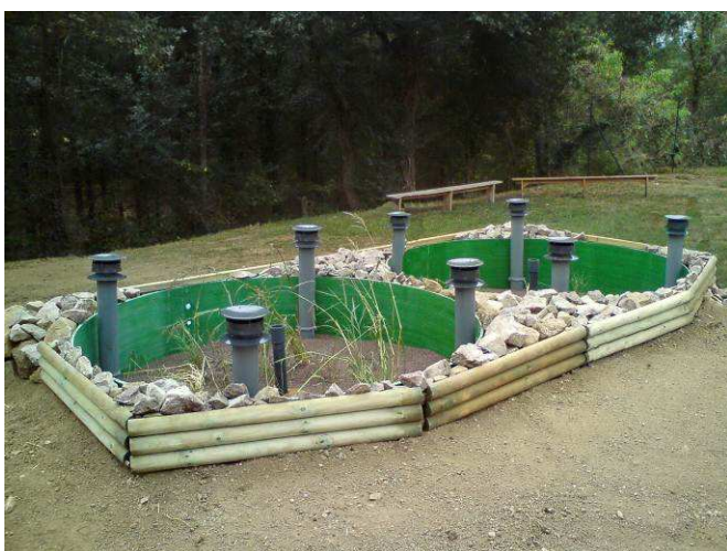
Vue des cuves Ecophyltre® (implantation enterrée)
