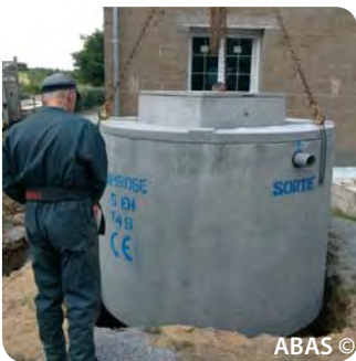
Accès libre autour du fond de fouille
