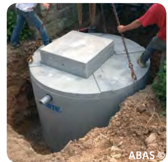
Largeur de la fouille : 3,0x3,0 m - SB 4/5/6
