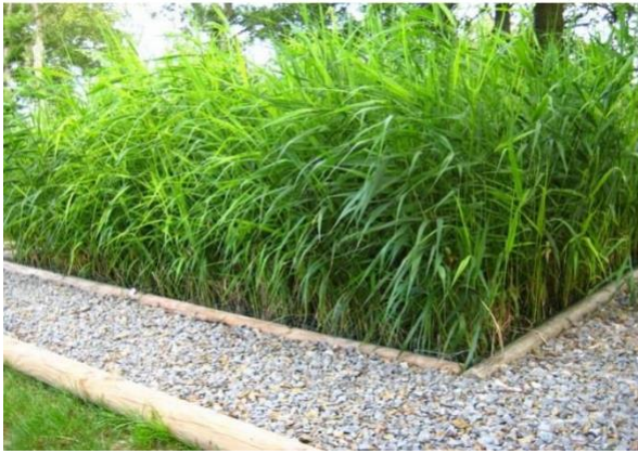
Filtre à écoulement vertical en saison végétative (la grille est camouflée par les roseaux)
